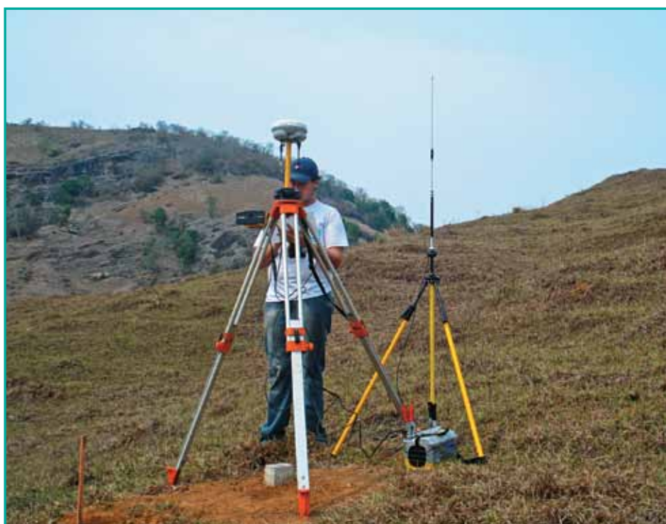
Com equipamentos de alta precisão, topógrafos demarcam a extensão do reservatório
